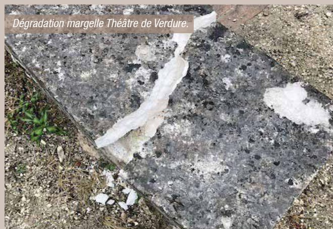
Dégradation margelle Théâtre de Verdure.
